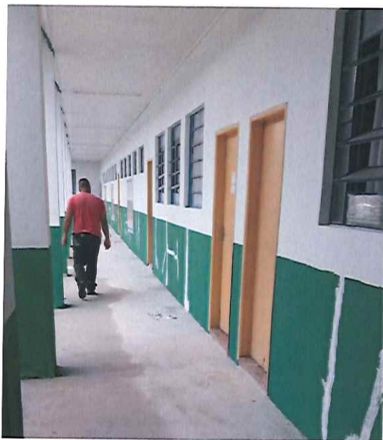
PISO DE CONCRETO APÓS A MANUTENÇÃO ( 19/12/2019 - 11:11)
