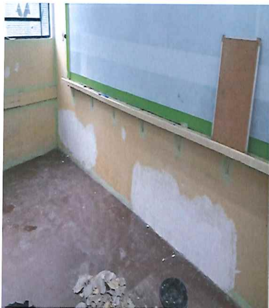
PINTURA DURANTE A MANUTENÇÃO (23/12/2019 - 17:50)
