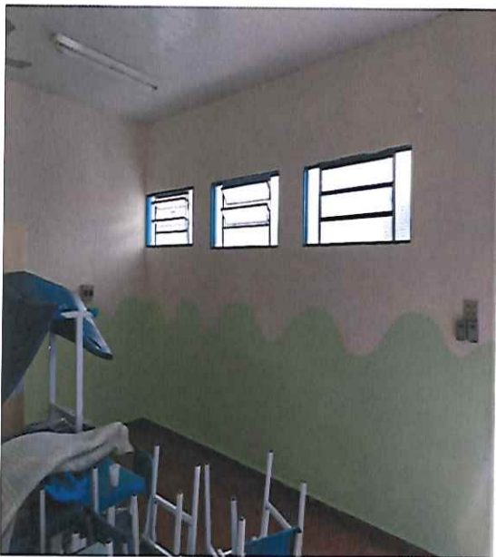
PINTURA APÓS A MANUTENÇÃO (08/01/2020 - 16:40)
