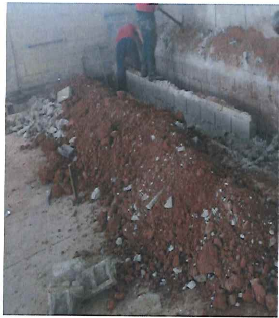
ARQUIBANCADA DURANTE A DEMOLIÇÃO (10/12/2019 - 16:51)
