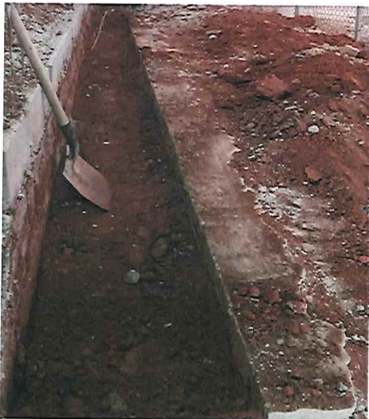
ARQUIBANCADA APÓS DEMOLIÇÃO (16/12/2019 - 09:19)
