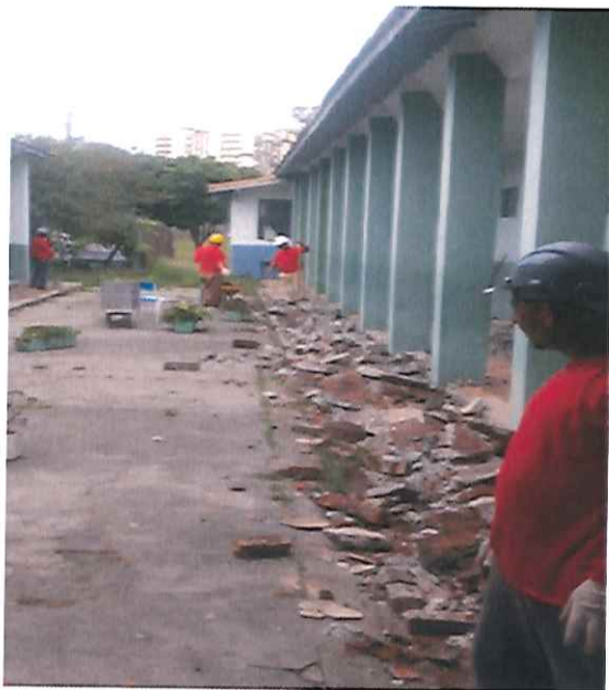
PISO DE CONCRETO DURANTE A MANUTENÇÃO (09/12/2019 - 15:19)
