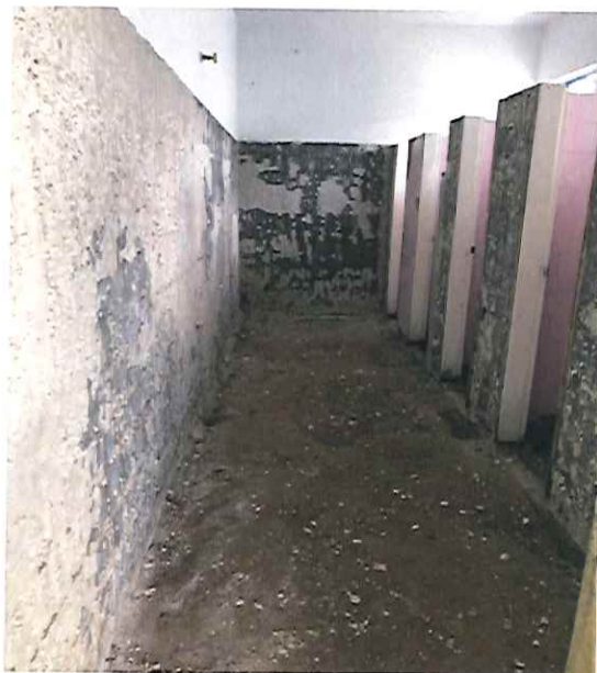
PISO CERÂMICO DURANTE A MANUTENÇÃO E APÓS A DEMOLIÇÃO 15/10/2019 - 15:15
