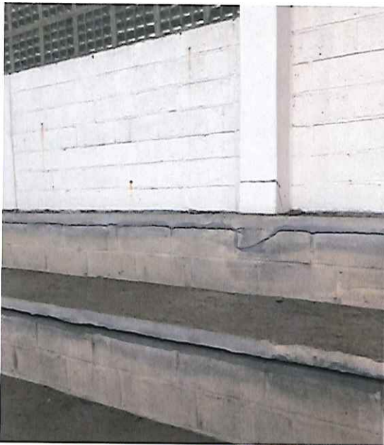
ARQUIBANCADA ANTES DA DEMOLIÇÃO (15/10/2019 - 15:20)
