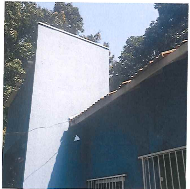
TELHADO ANTES DA MANUTENÇÃO (04/09/2019 - 10:42)
