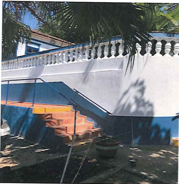
PINTURA APÓS A MANUTENÇÃO; (18/11/2019 - 10:40)
