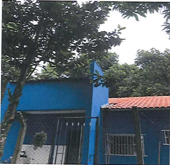
TELHADO APÓS A MANUTENÇÃO; (18/11/2019 - 10:13)
