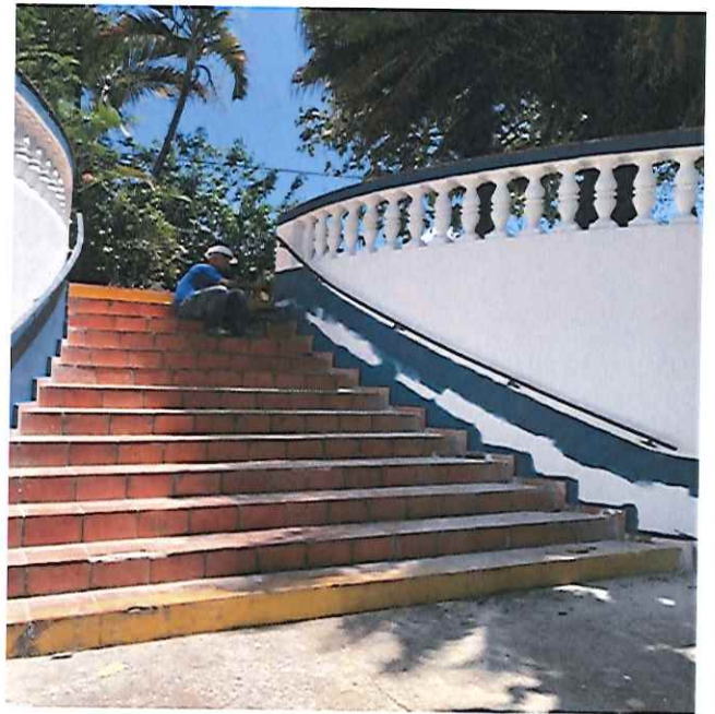
PINTURA DURANTE A MANUTENÇÃO; (18/11/2019 - 10:10)
