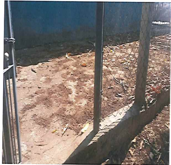
PISO DE CONCRETO ANTES DA MANUTENÇÃO; (04/09/2019 - 10:38)
