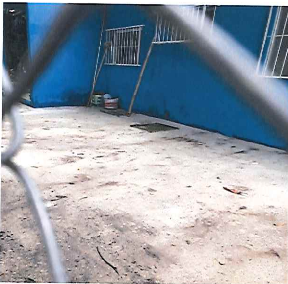
PISO DE CONCRETO APÓS A MANUTENÇÃO (16/12/2019 - 11:13)
