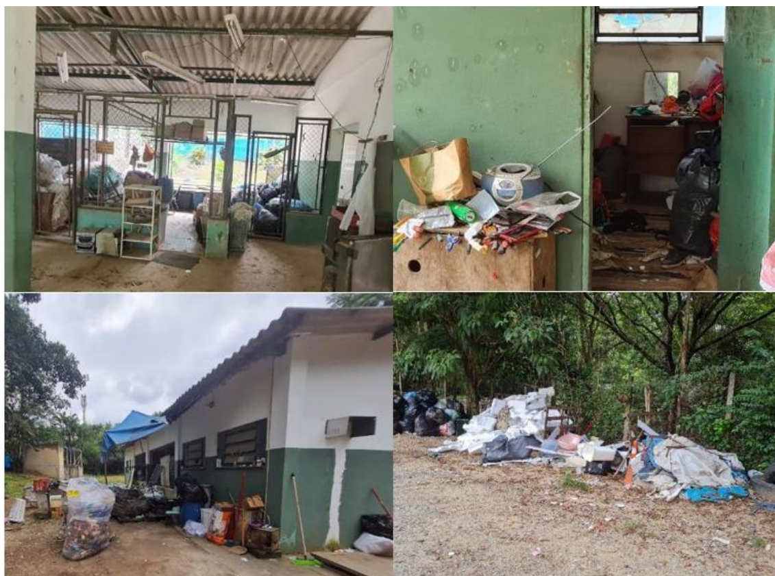
Figura 34: KATURETÊ – precariedade local
