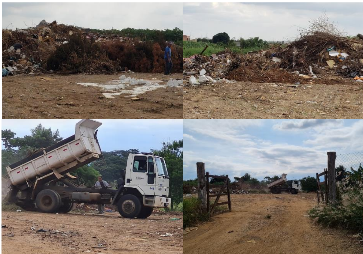
Figura 66: Aterro de inertes municipal Fonte: Felco Faleiros – fotografia tirada em 07/04/2022
